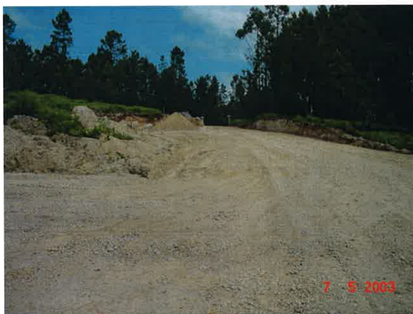
Foto 11 – Alargamento dos caminhos de acesso
